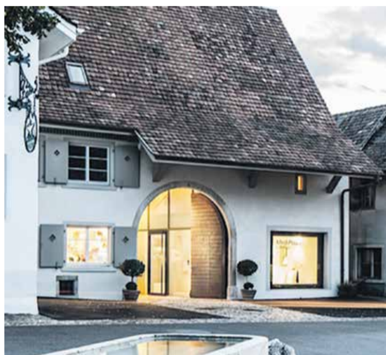
Nachher: Aus der Schlosserei wurde ein Mehrgenerationenhaus u.a. mit einer Podologiepraxis und einem Coiffeursalons. Der Charakter des Gebäudes blieb erhalten. FOTOS VVG
