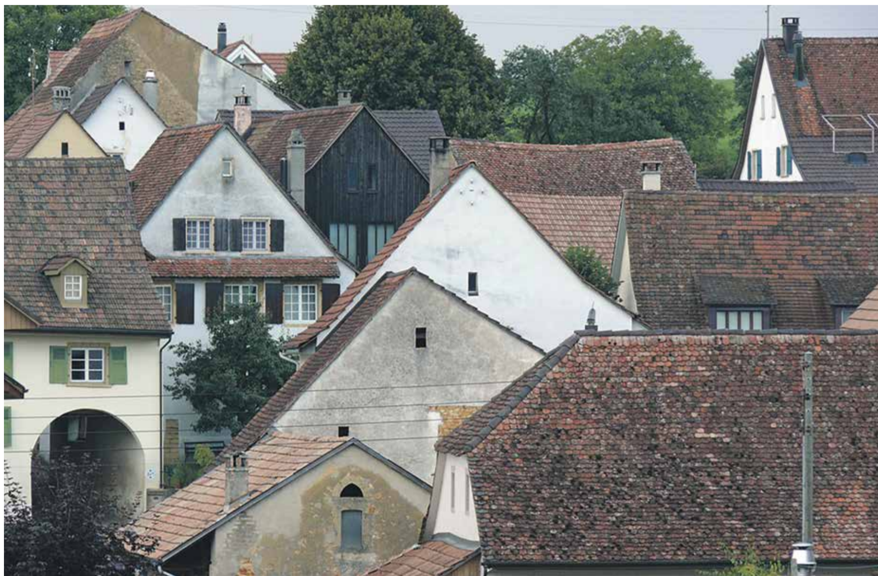
Aufgrund der Anforderungen der Denkmalpflege waren viele Sanierungen im Baselbiet bisher zu aufwendig. Im Bild: ein Blick über die Dächerlandschaft der Gemeinde Wenslingen. FOTO ARCHIV
